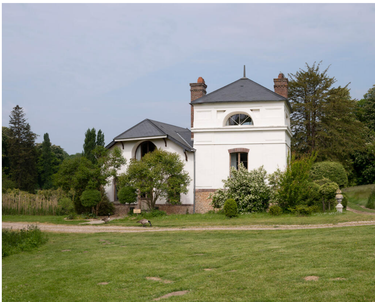
Le pavillon dit du moulin, construit sur l'un des bâtiments de l'ancienne ferme.
