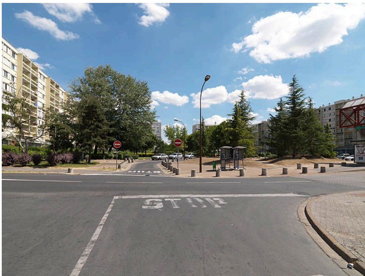
Cité dite Résidence Saint-Hubert. Vue d'ensemble du U depuis la structure en métal rouge de l'ancien centre commercial.
