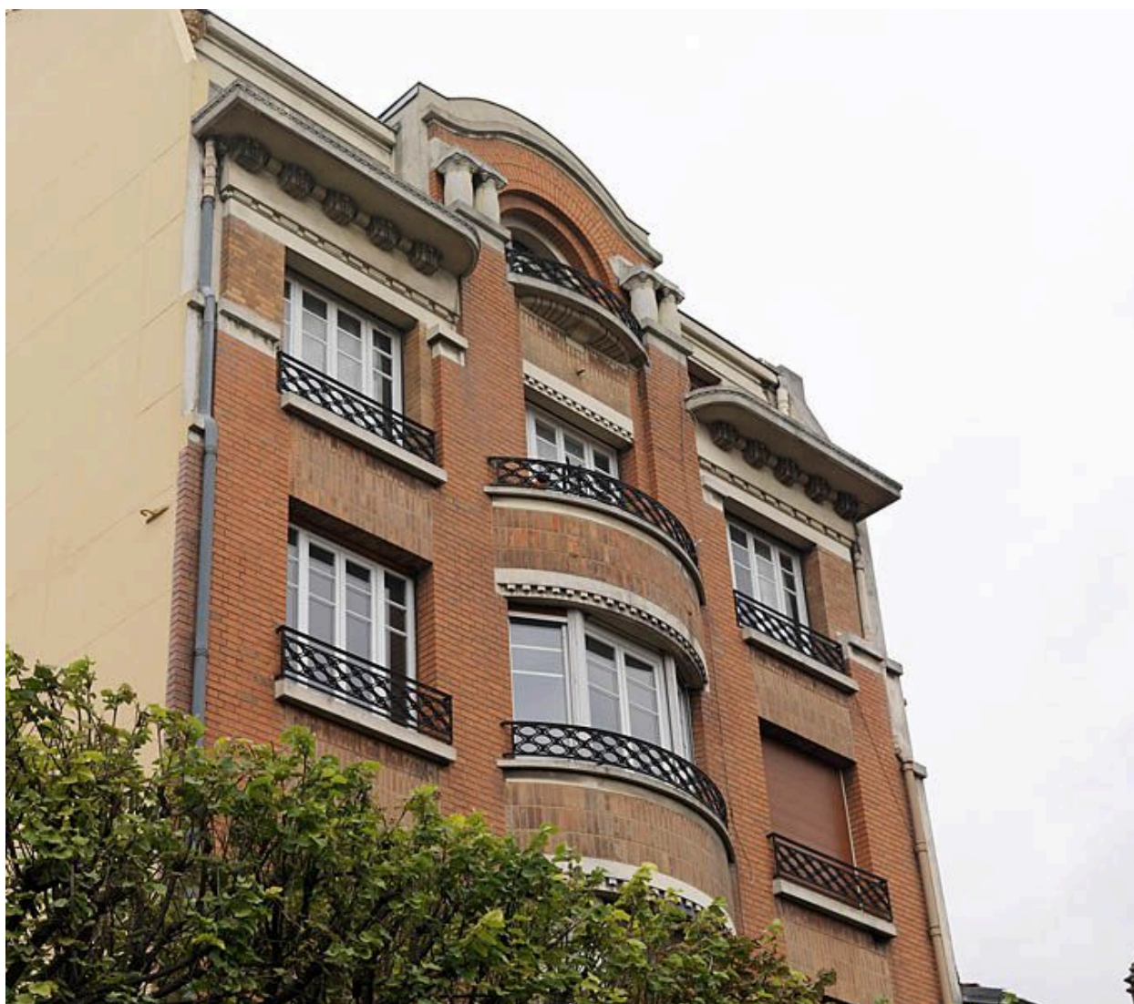
Vitry-sur-Seine, immeuble d'architecte, 100 avenue Paul Vaillant Couturier. Vue partielle de la façade avec des balcons de forme arrondie.
