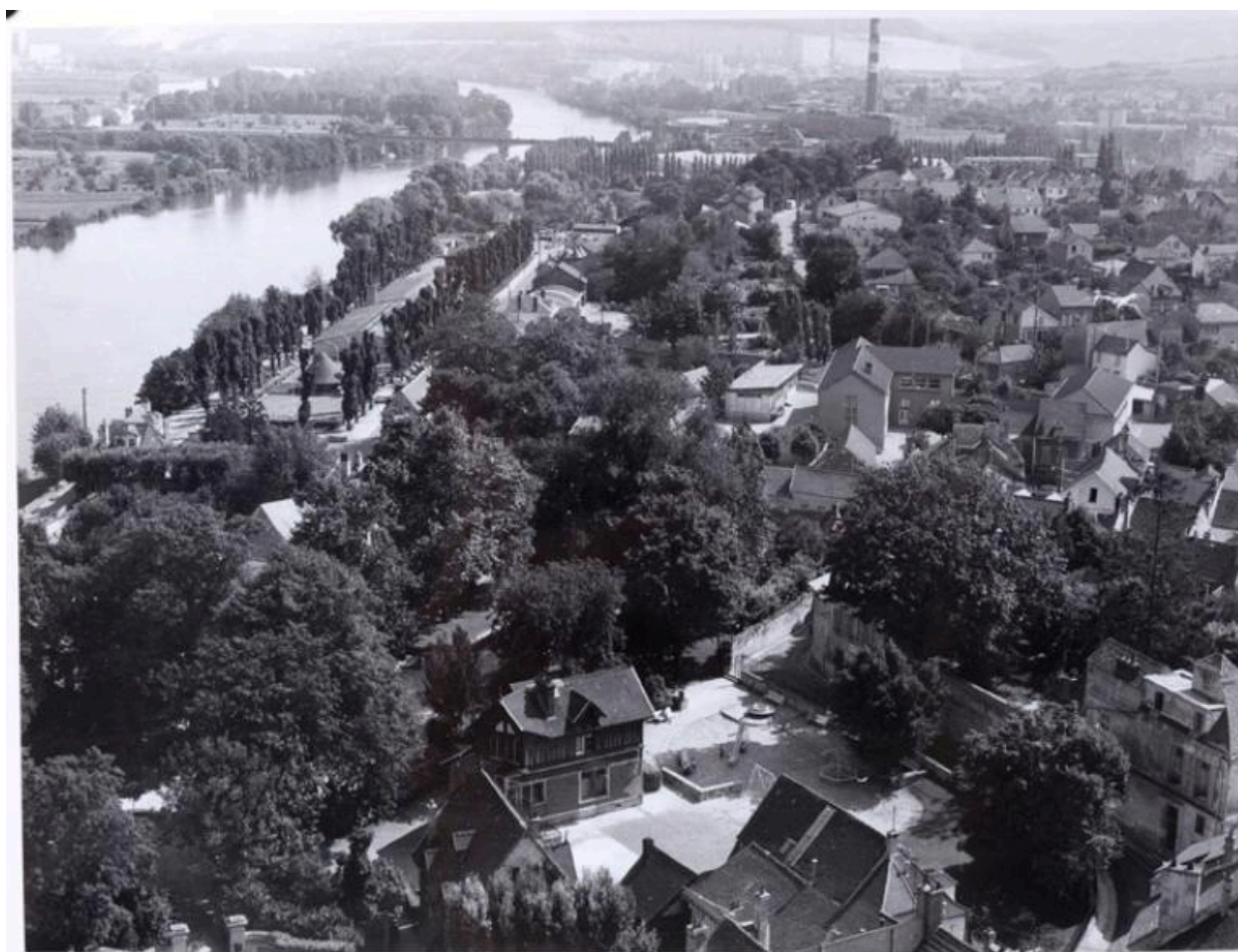
Vue du square du château. (Fonds CREDOP).
