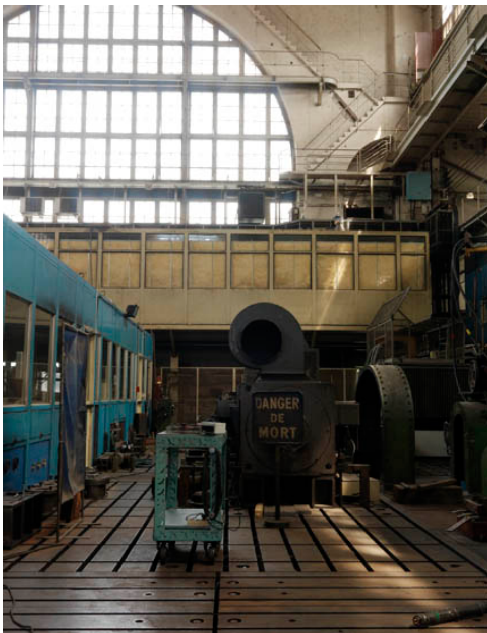
Vue intérieure. Plateforme d'essais. Entreprise Jeumont-Electric.
