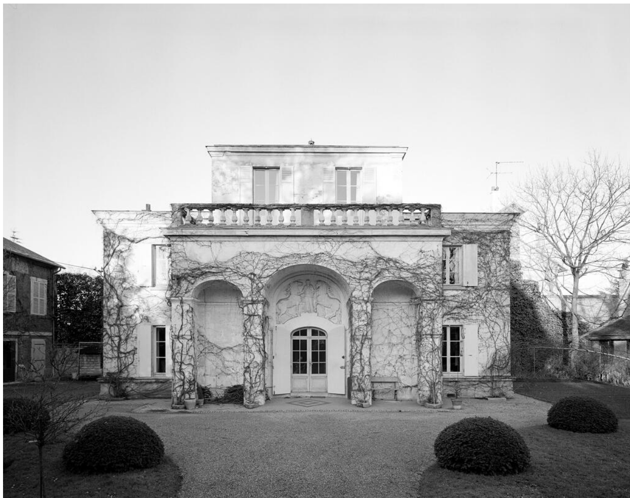
Ecuries. Façade antérieure de la maison construite autour de l'abreuvoir en 1883 dite maison de la Grotte.
