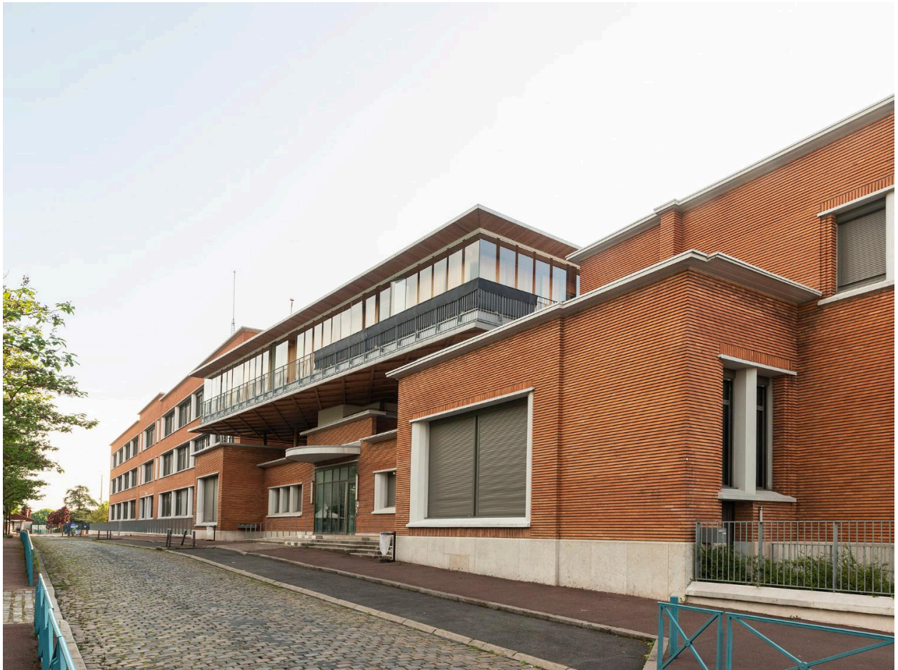
Détail de la surélévation vitrée érigée en surplomb de l'école maternelle et abritant des logements. Vue latérale.
