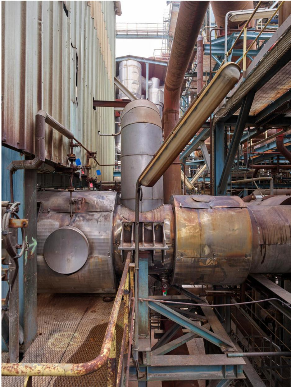
Unités Est - Zone FCC (Unité 651). Vanne "Adams" papillon servant à admettre les fumées dans la turbine du compresseur K1001.
