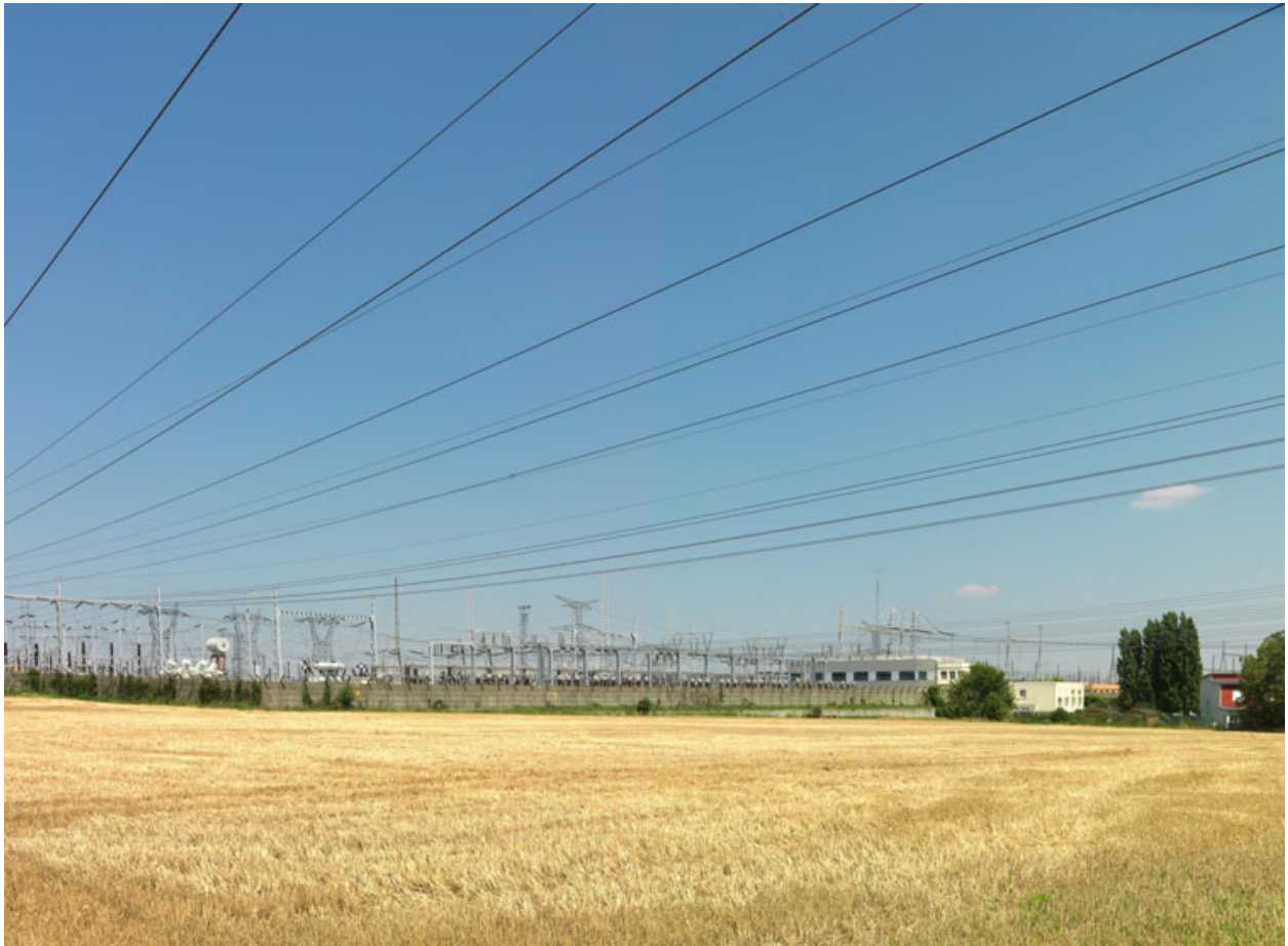
Lignes électrique haute tension et transformateur.
