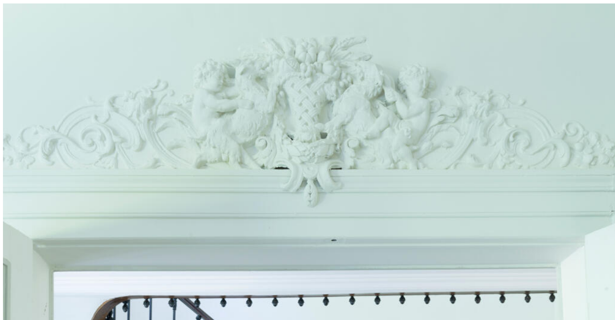
Moulure surmontant une porte intérieure de la pièce sud-ouest du rez-de-chaussée.
