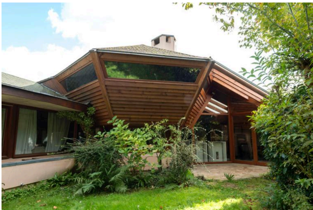
Vue rapprochée de la façade postérieure.
