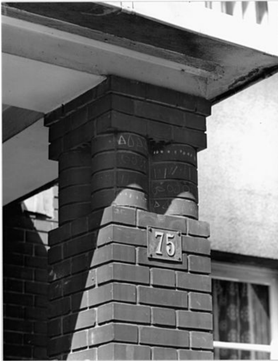
Détail d'un pilier de porche, 75 rue Francis-de-Pressencé.
