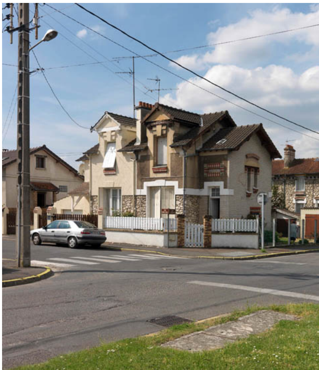
Ancien pavillon du directeur converti en logements.
