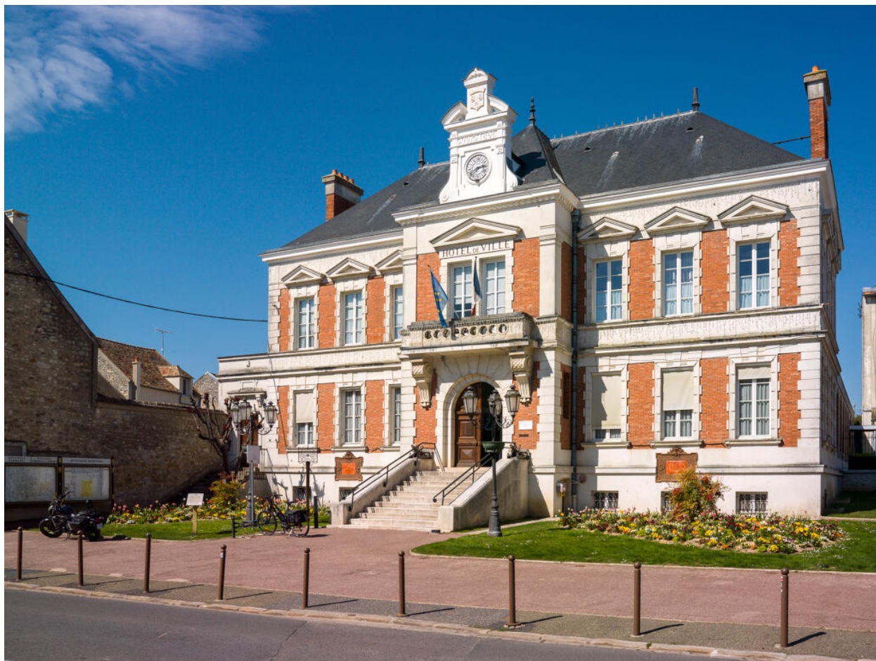
Vue de l'angle sud-ouest de la façade principale de l'Hôtel de Ville de Milly-la-Forêt (orientée sud).
