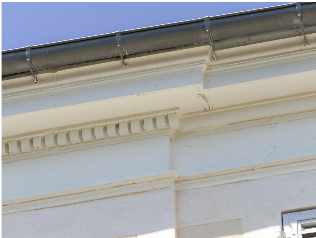
Vue de détail de l'entablement couronnant la façade donnant sur cour depuis l'angle sud-est.
