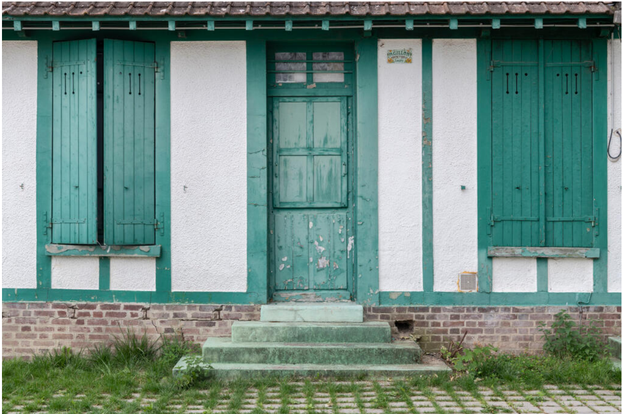
Société Nautique de Lagny - Détail d'une porte annexe de la maison de gardien avec la plaque de l'architecte Gillon à Lagny.
