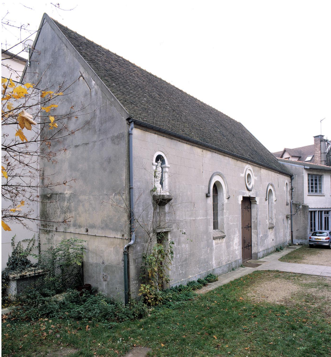
Vue d'ensemble de la chapelle.
