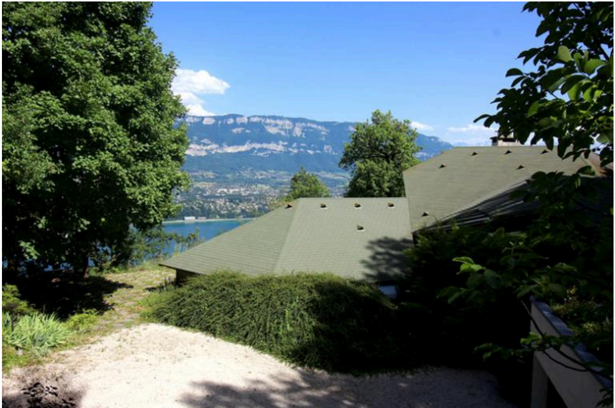
Vue rapprochée d'une partie de la toiture.
