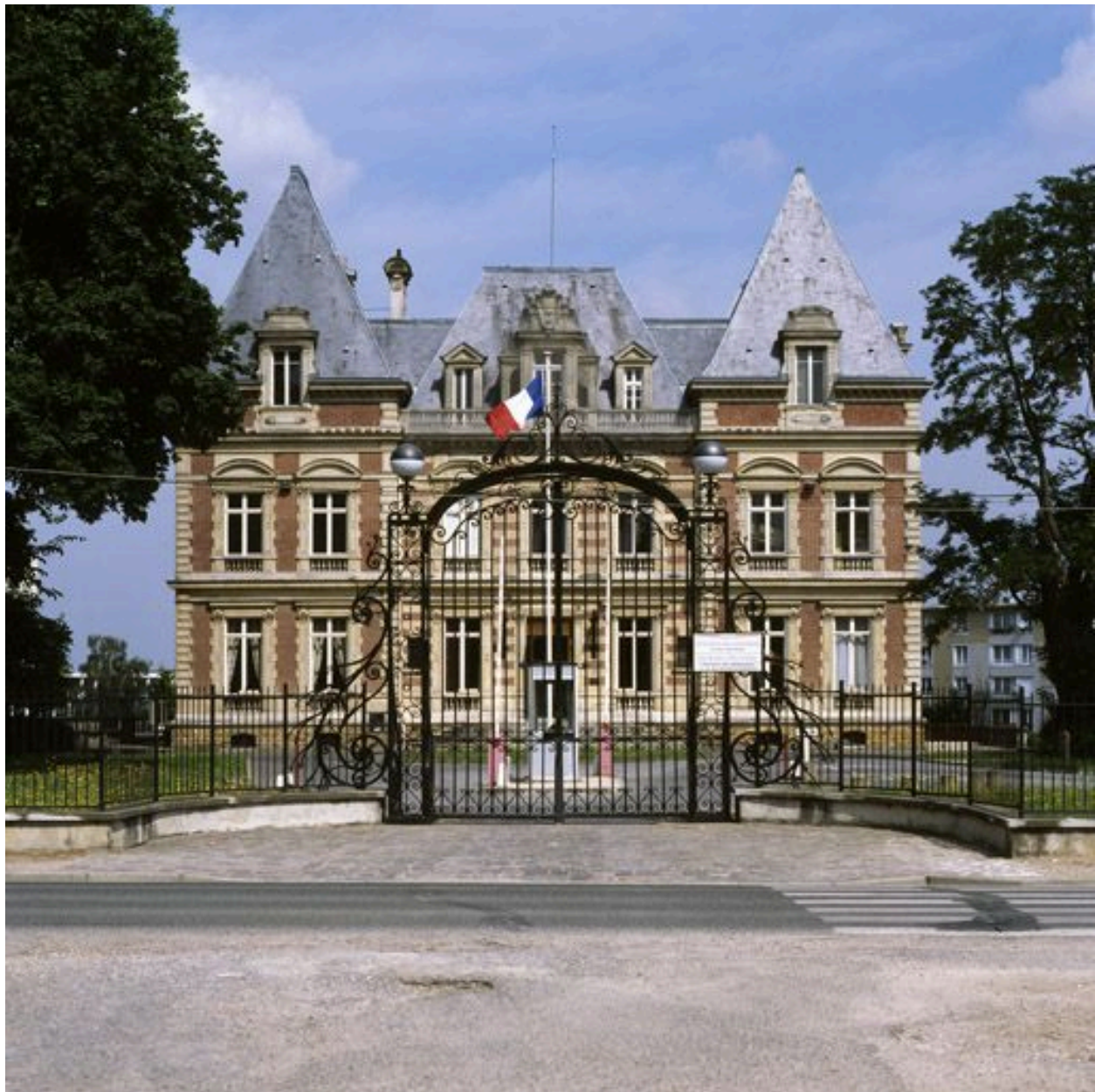
Vue d'ensemble derrière la grille d'entrée.
