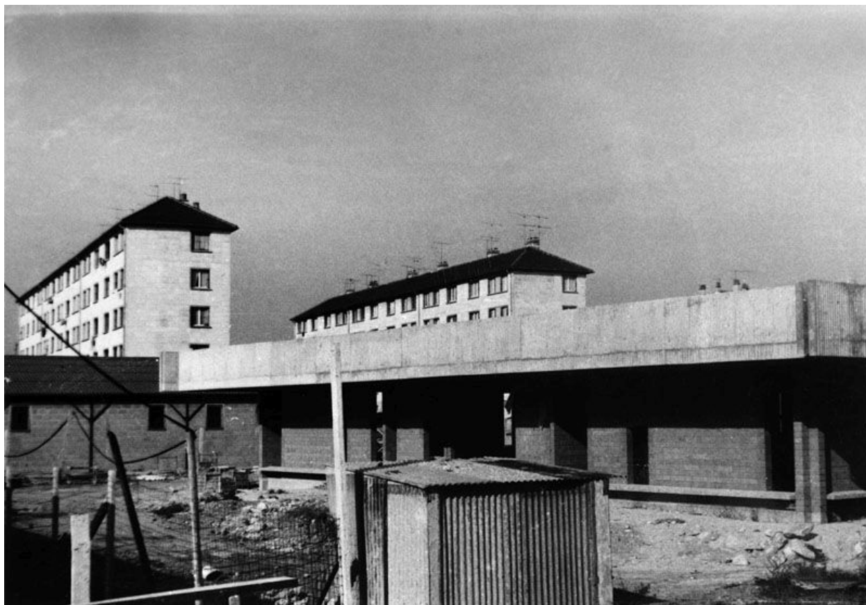
Façade ouest lors du chantier de construction. Photographie ancienne, circa 1968. (Collection particulière)
