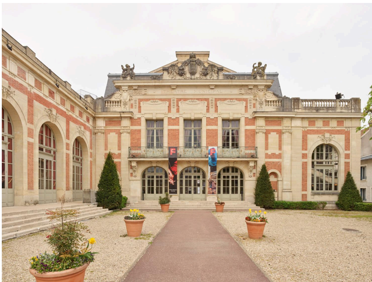
Façade principale sur cour du théâtre
