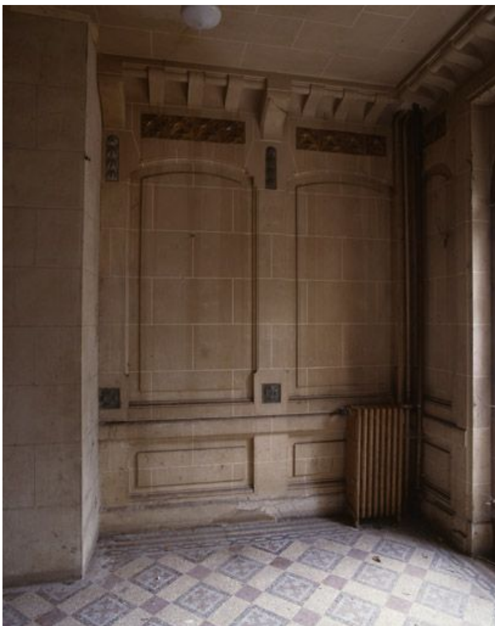
Mur latéral du hall d'entrée.
