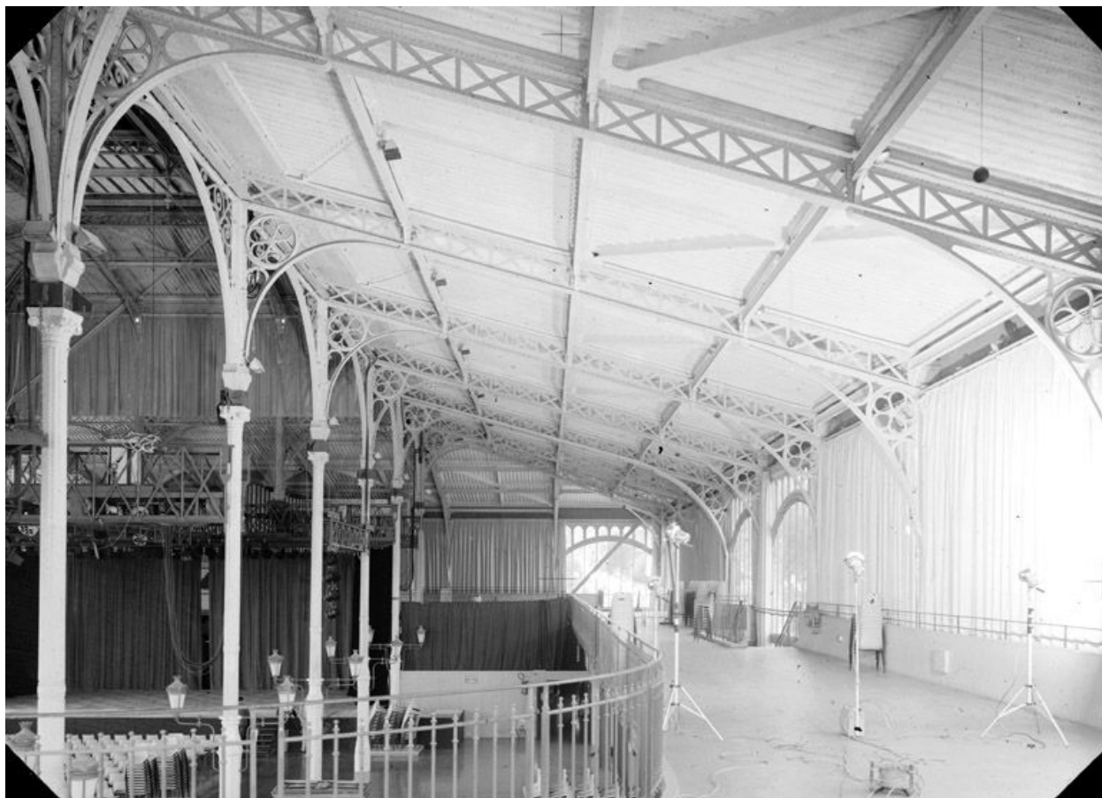
Fermes transversales. Couple photogrammétrique.
