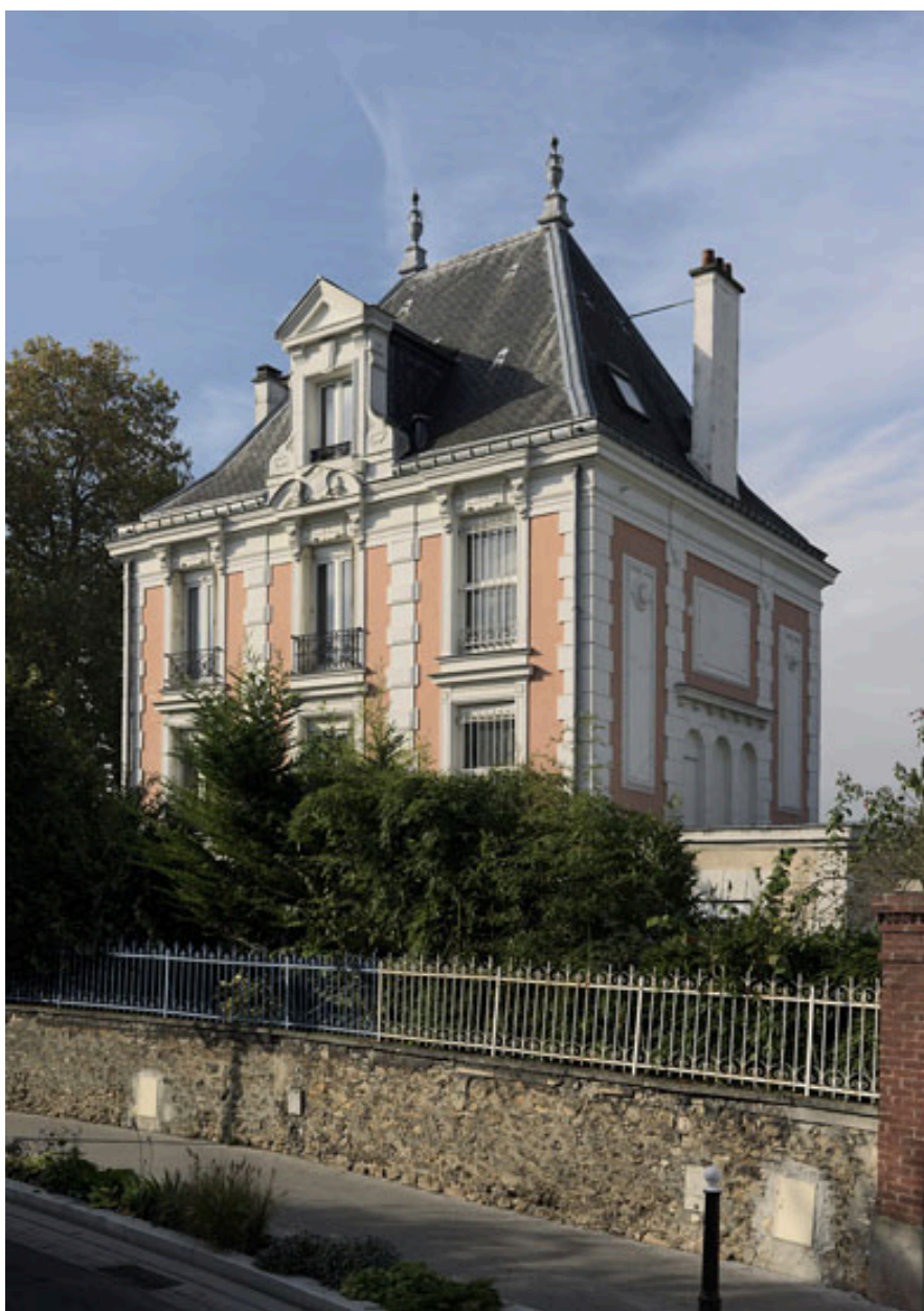
Vue de la façade antérieure et de la façade latérale.
