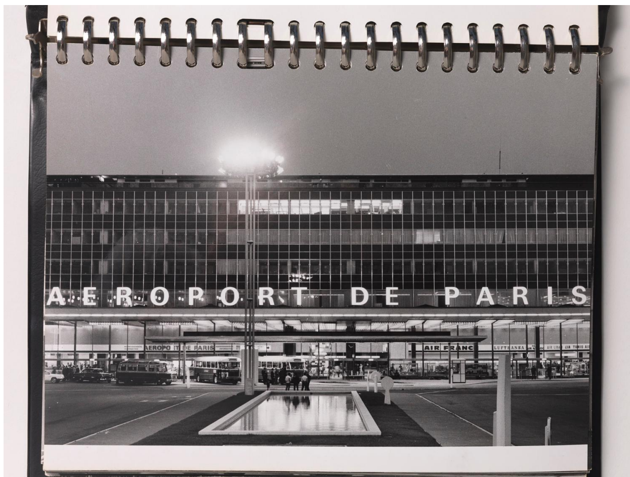
Le parvis du Grand Hall, "Orly Installations Terminales", album de photographies destinées à la presse édité par l'Aéroport de Paris, 1961.
