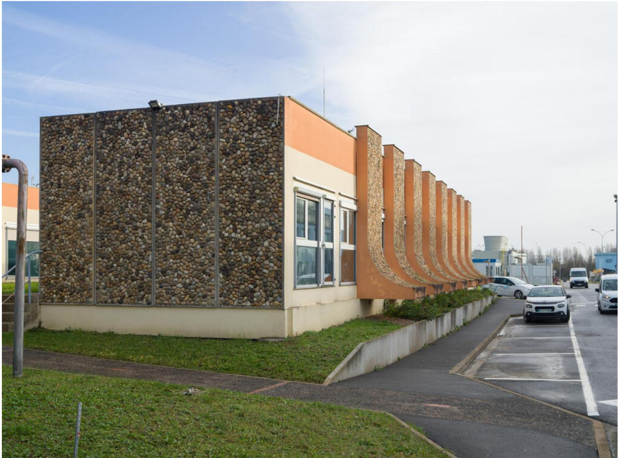
Partie sud du bâtiment salle de contrôle, abritant les services supports rattachés à l'exploitation. Les "virgules" en béton armé, datant de 1979, sont progressivement supprimées depuis les années 2000 en raison de leur instabilité potentielle en cas d'explosion.
