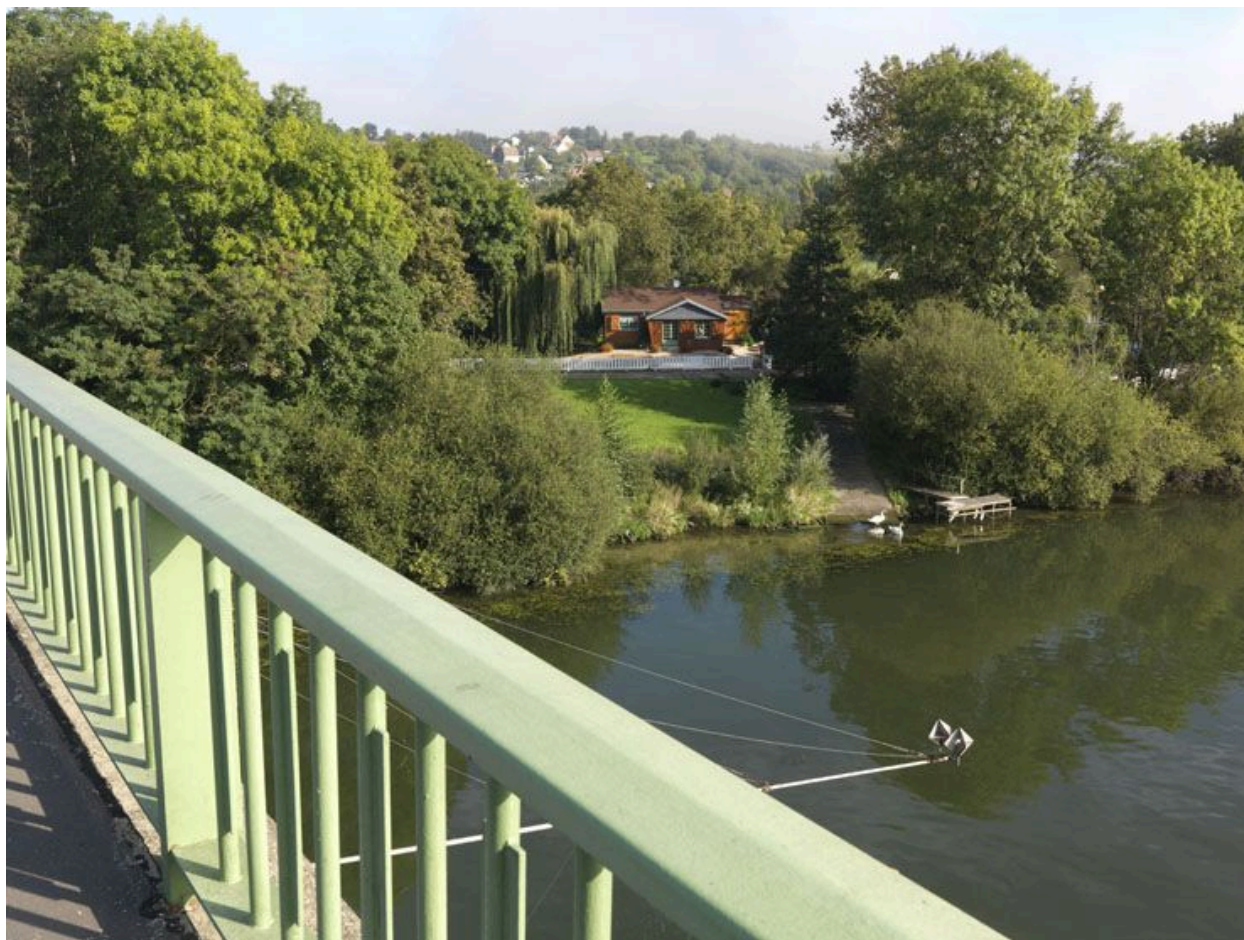
Vue depuis le pont routier vers l'amont sur la Grande Ile.
