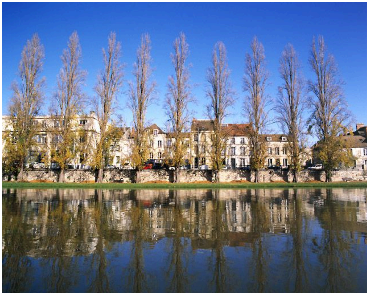
Vue d'ensemble du quai d'Alsace-Lorraine.
