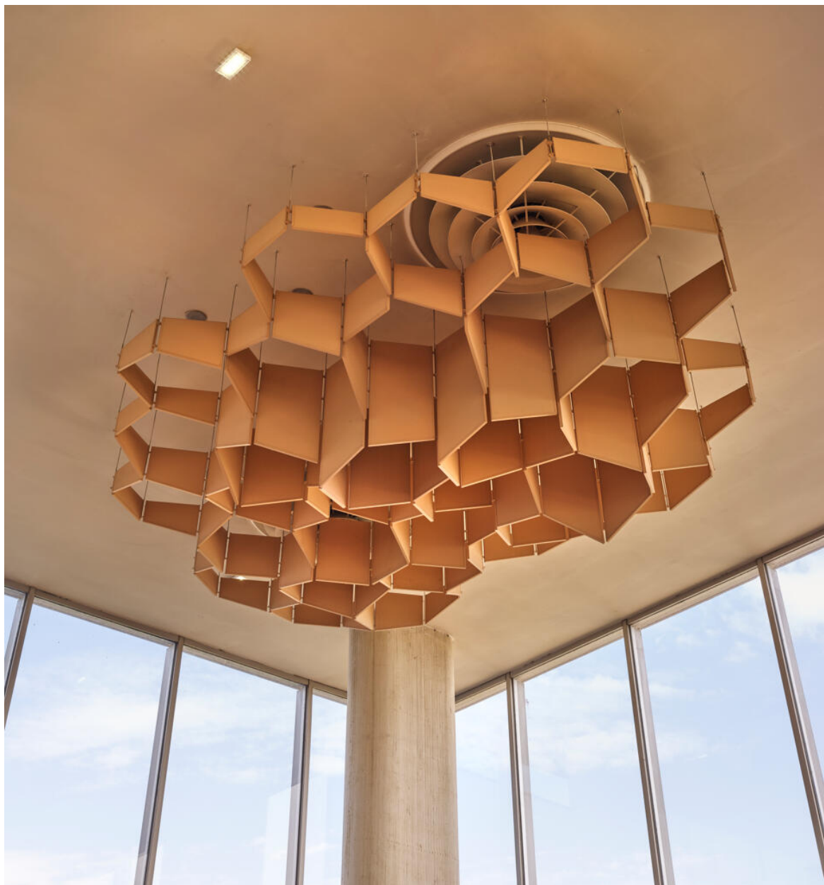
Salle des fêtes. Détail d'un nid d'abeille, destiné à atténuer l'effet de résonance.
