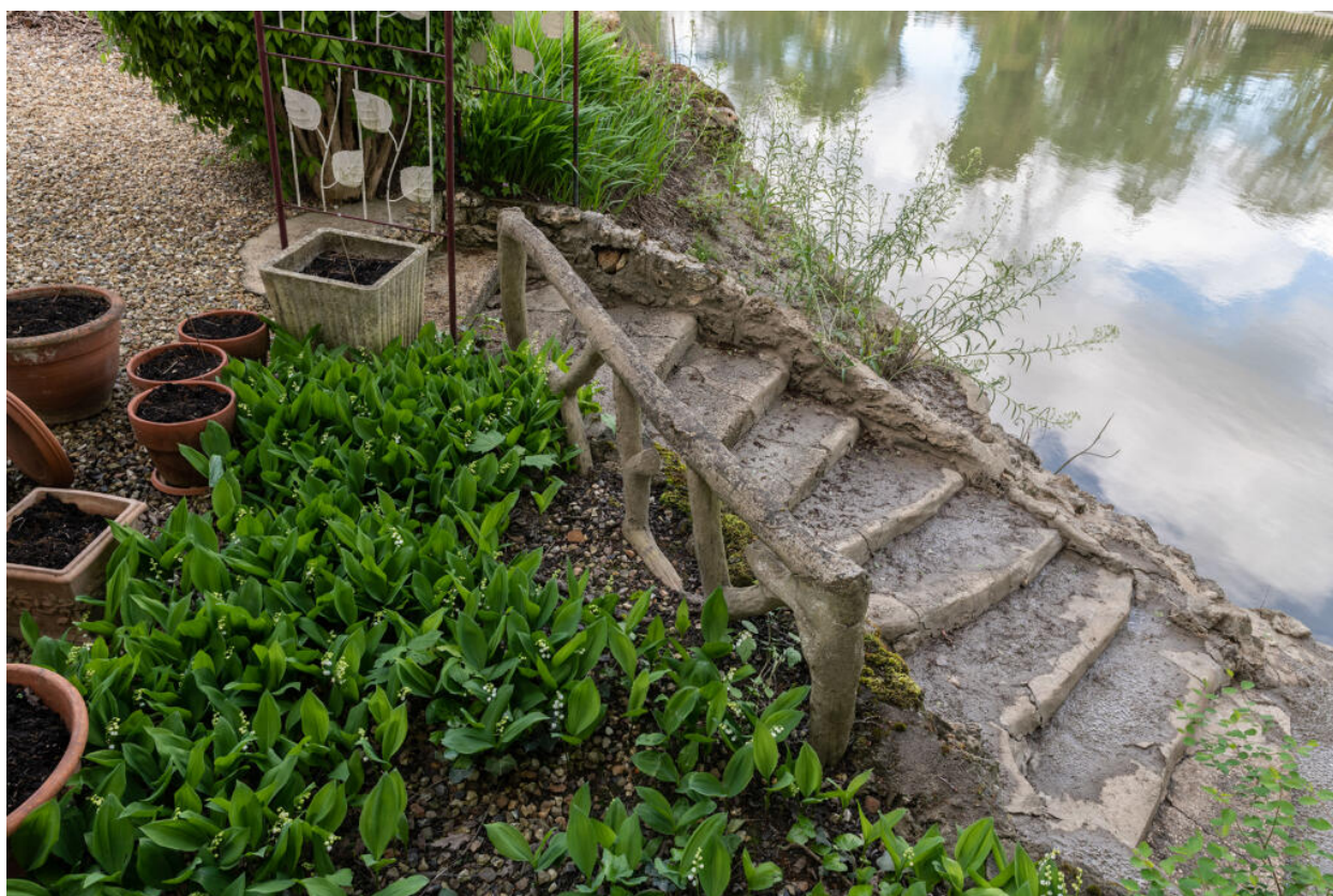
L'escalier en béton rustiqué menant au ponton.
