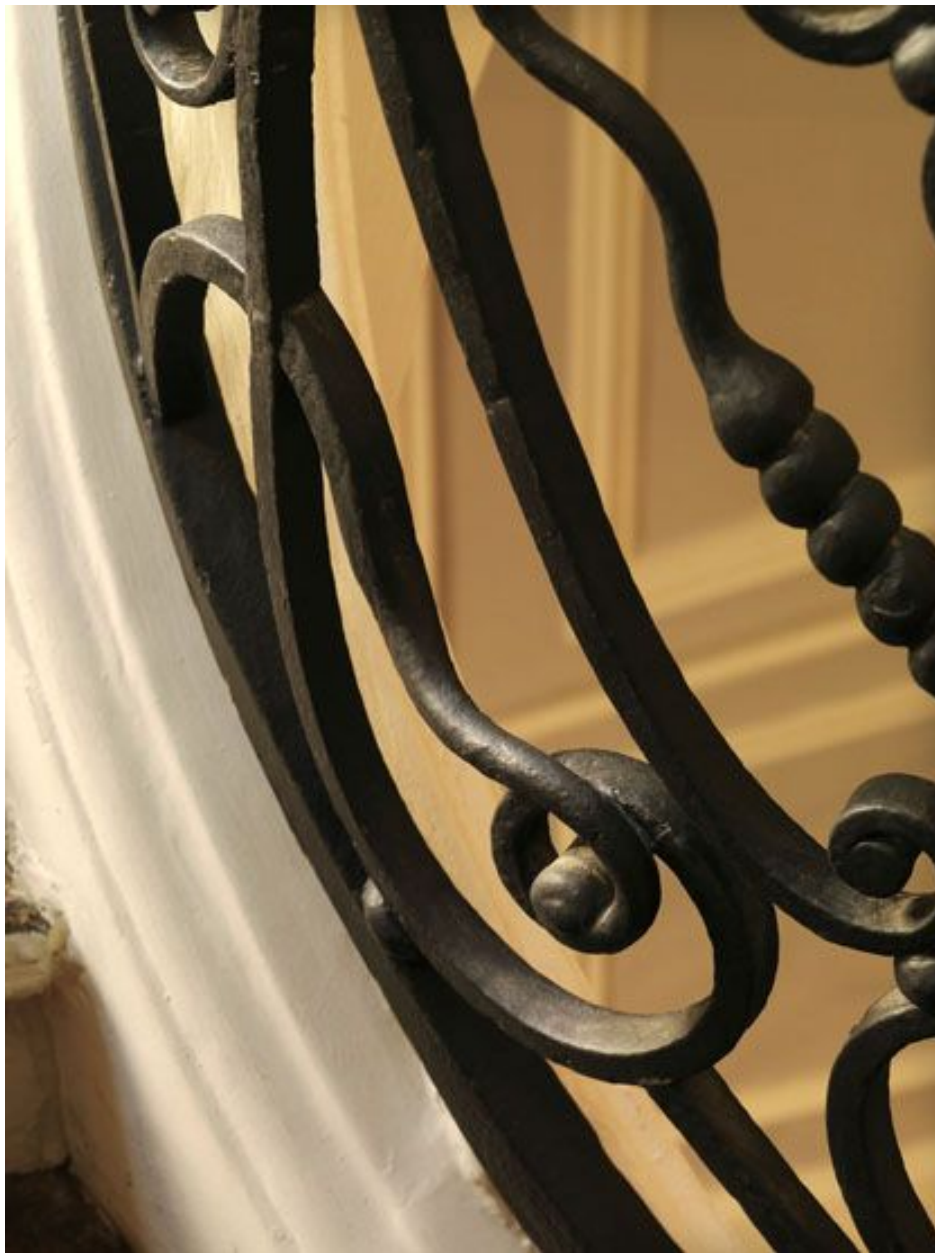
Détail d'un ornement en fer rond puis carré dans le premier panneau tournant.
