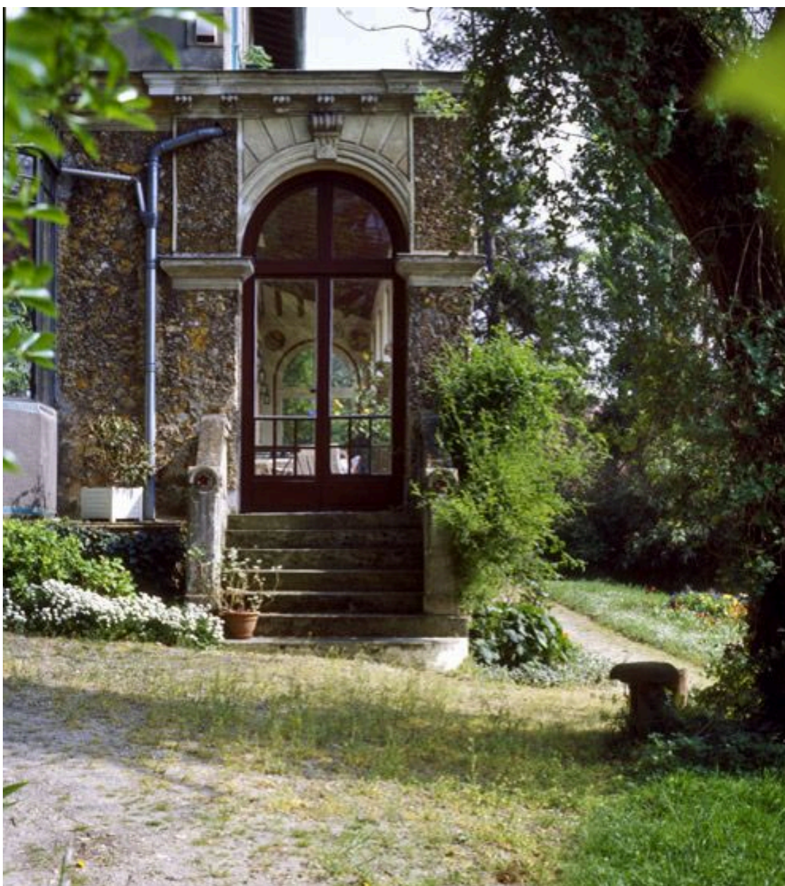
Maison, 23 avenue Martelet. Villa construite sur le coteau méridional au milieu des années 1880. Détail de l'accès à la galerie. Boussard, Jean-Marie (architecte)
