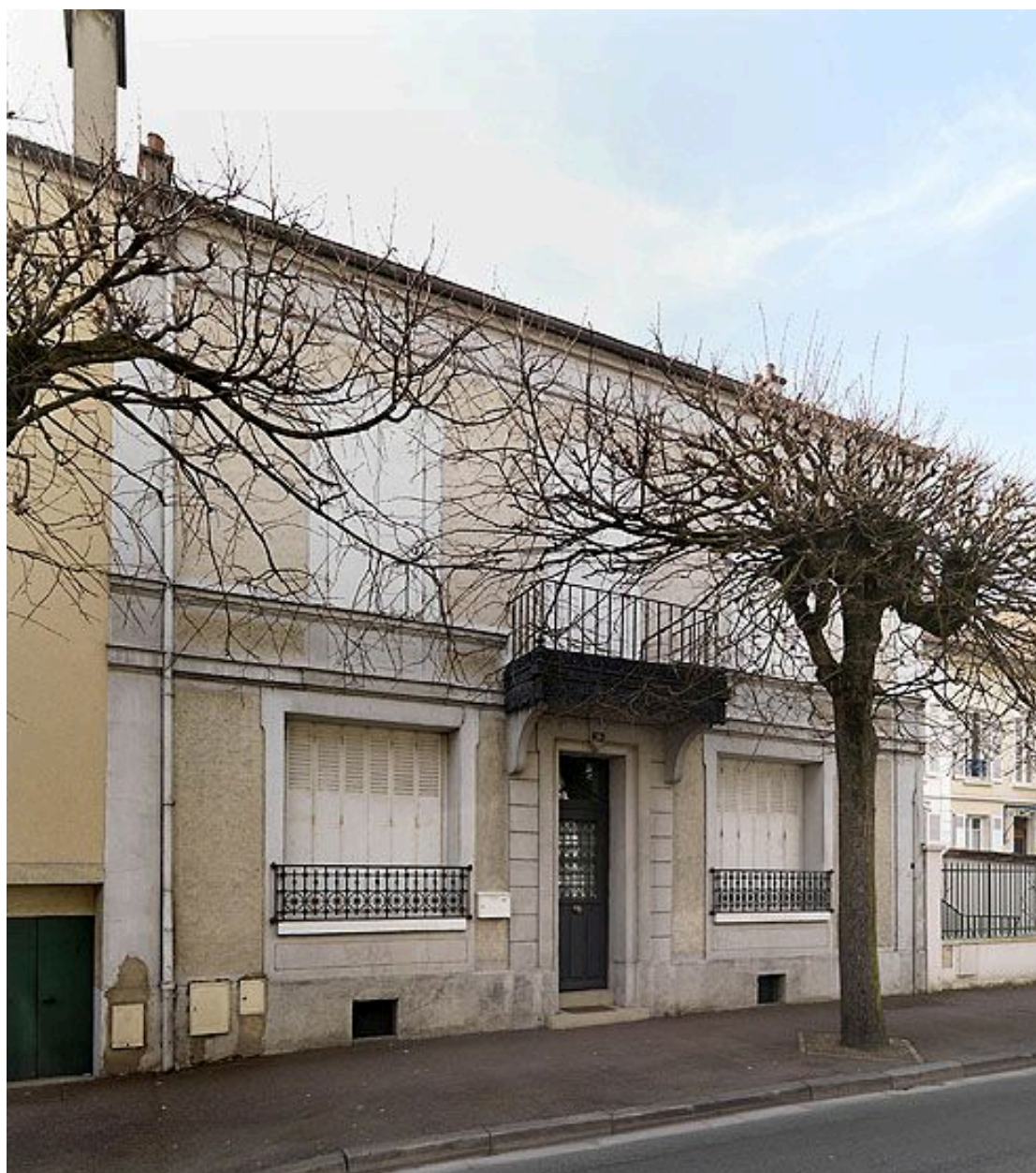
Maison 28 avenue de la République, avec balcon en fonte : vue d'ensemble de la façade.
