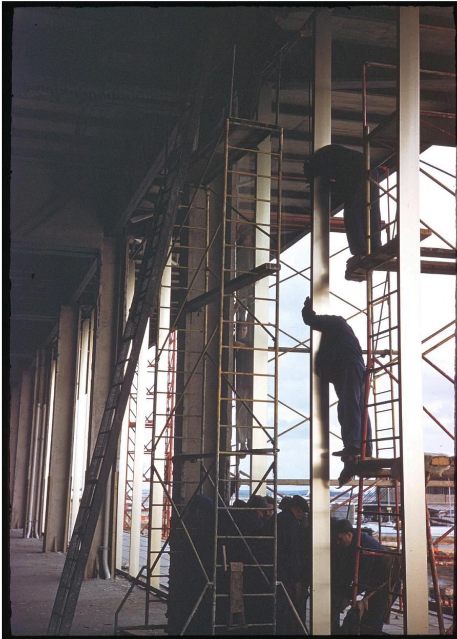
1957 1961, la construction des Installations Terminales: l'installation des dalles en verre du mur-rideau de la façade sud, vue prise depuis la future Galerie Marchande au 1er étage.
