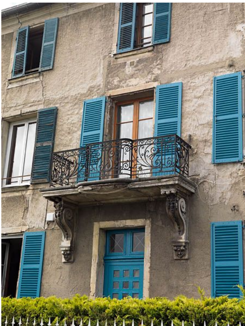
Ablon-sur-Seine, château, actuellement immeuble, 5 rue de l'Eglise. Elévation sur la Seine, détail du balcon en fer forgé reposant sur des consoles à volutes.
