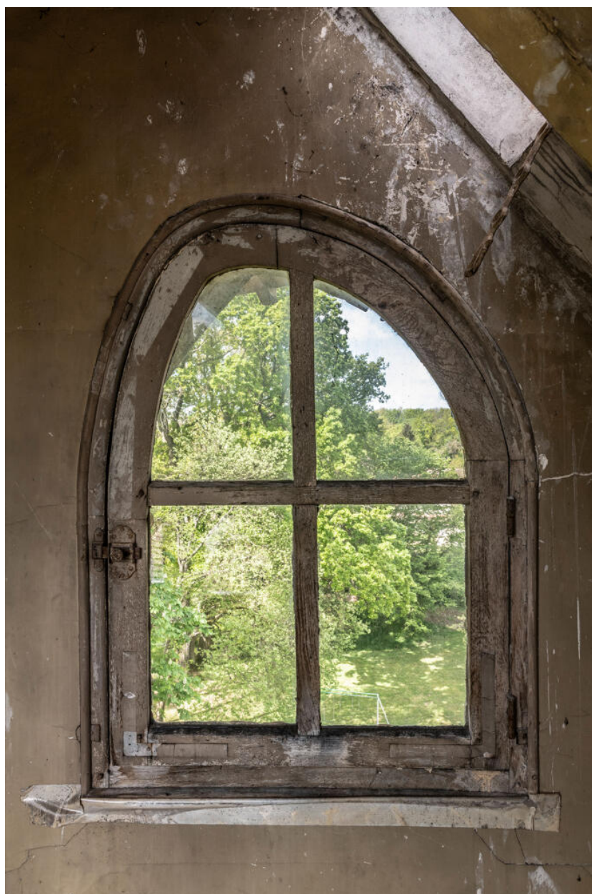
Fenestron en biais dans le belvédère.
