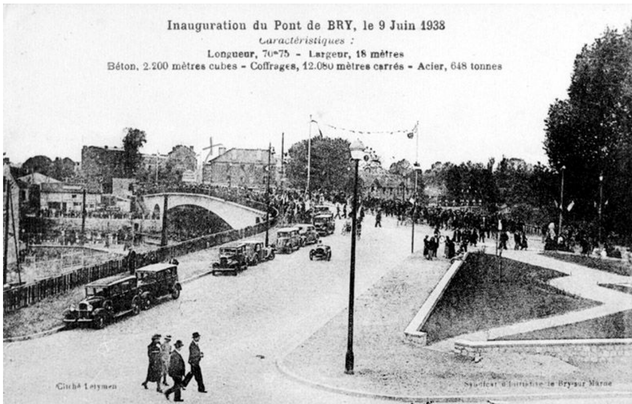
Vue de l'inauguration du pont en béton le 9 juin 1938. Carte postale. (Collection particulière)
