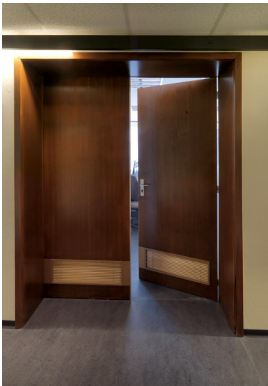
Porte à deux vantaux en bois d'une salle de réunion.
