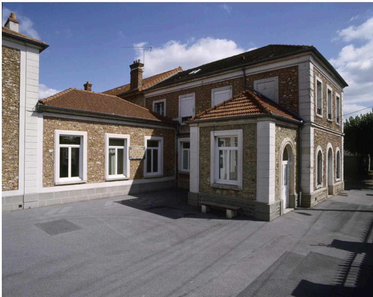
Vue latérale sur la cour de récréation de l'école de garçons construite en 1842.
