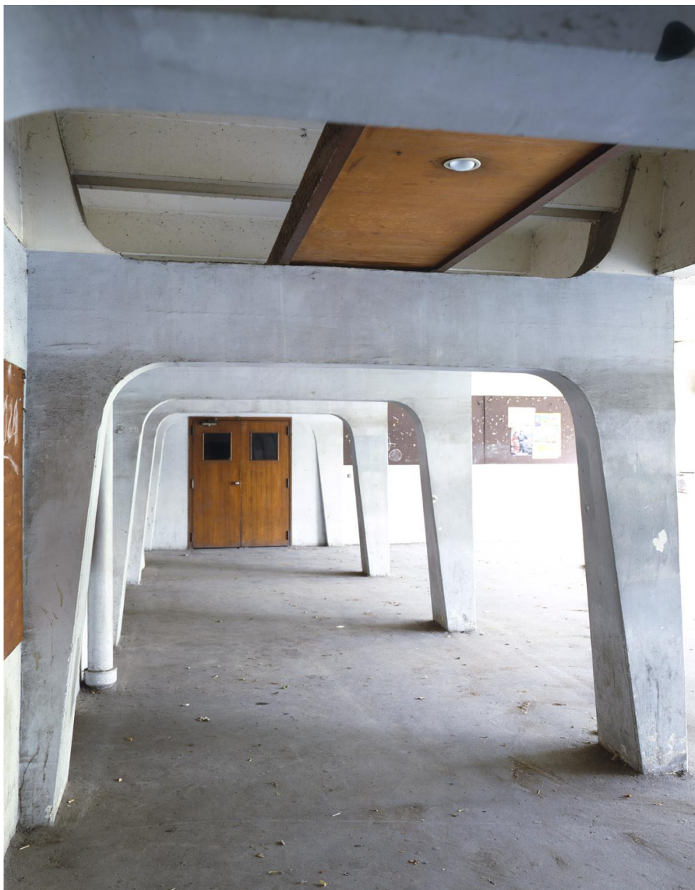
Détail des grands portiques de béton armé assurant le contreventement des bâtiments, au lycée de Sarcelles (Val-d'Oise, 1962).
