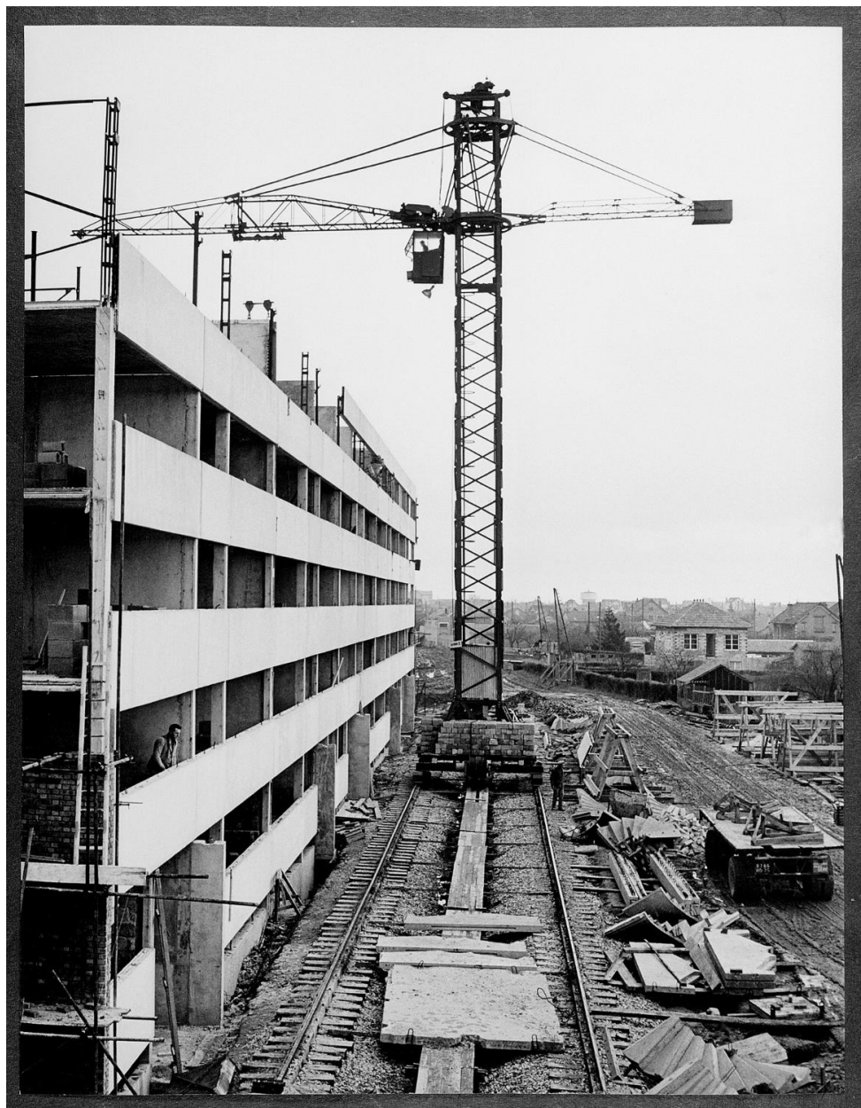
Construction des immeubles, chemin de grue, janvier 1959.
