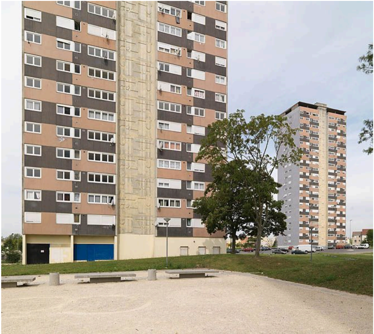
Deux tours de la Pierre-Collinet, en 2009 : détail de la mise en oeuvre.
