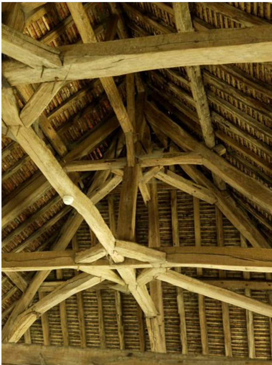
La charpente : détail d'une ferme.
