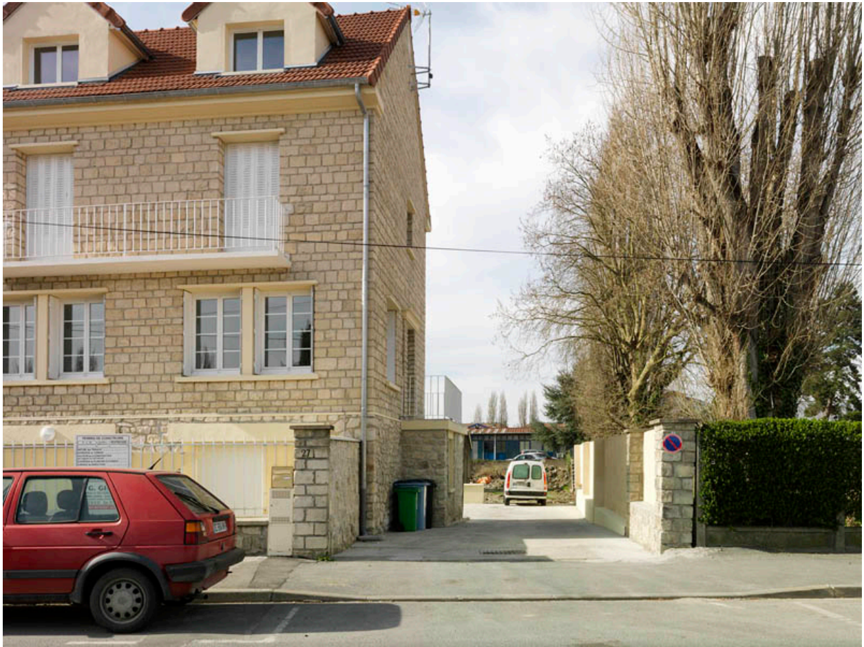
Persan. Le quai de l'industrie. Immeuble d'habitation. Élément de phrase urbaine.
