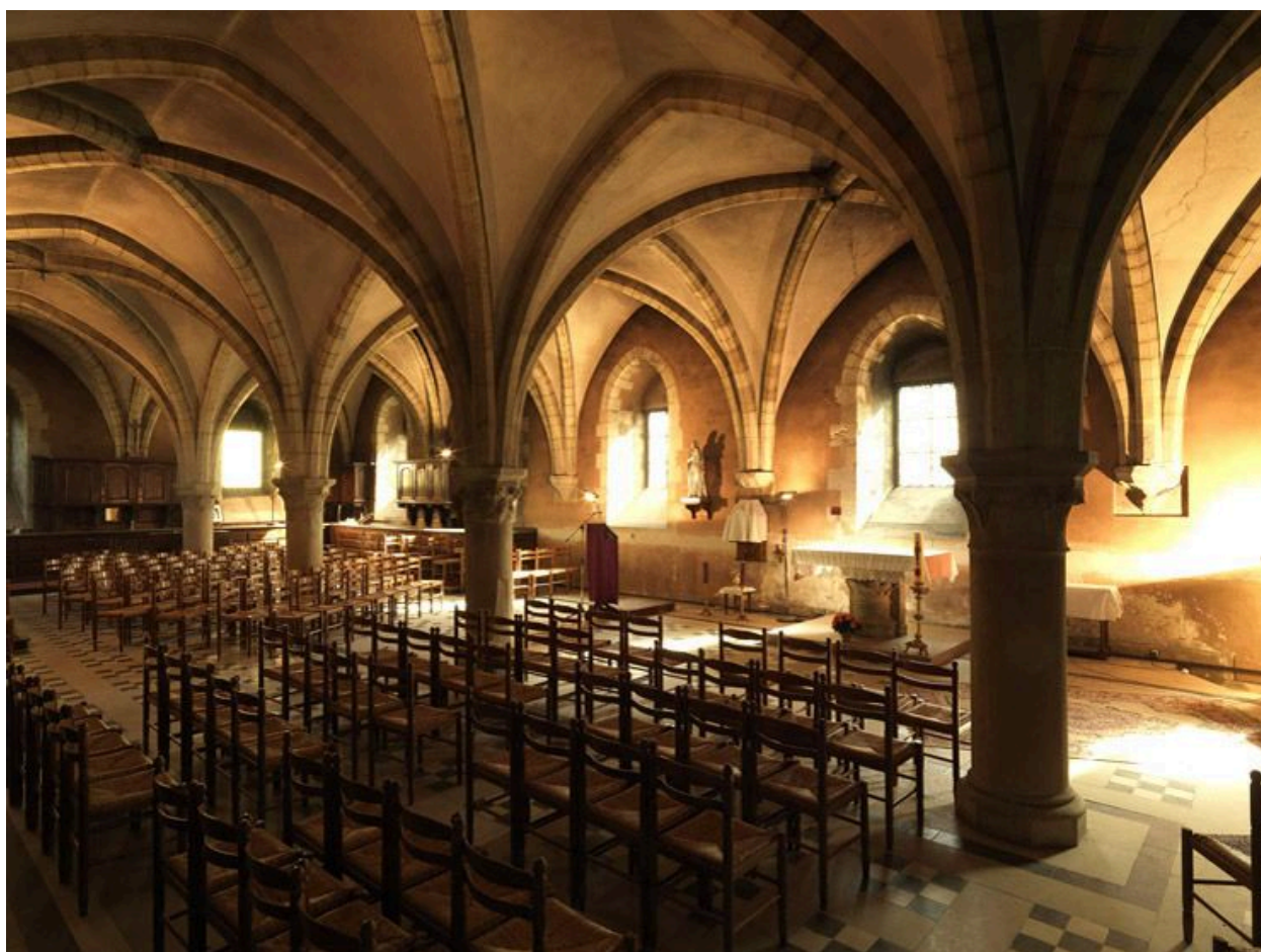
Le rez-de-chaussée : vue intérieure, depuis le sud-ouest.
