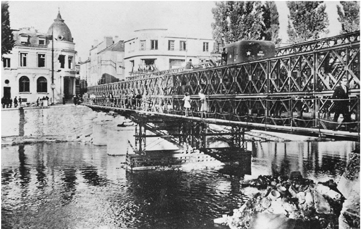
Passerelle temporaire élevée entre l'île Saint-Etienne et la rive droite, sur les ruines du pont de pierre détruit en 1944 lors de la Seconde guerre mondiale. Carte postale. (Musée municipal de Melun. inv. 971.15.20)
