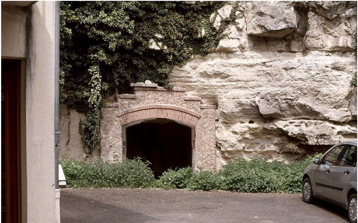
Entrée d'une ancienne carrière à Andrésy, rue de la Gare.
