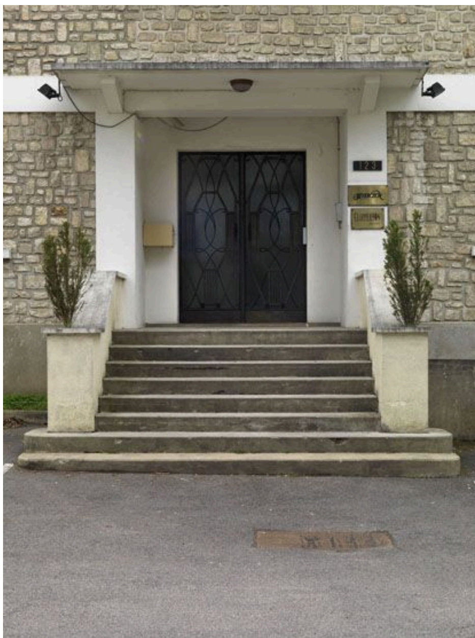
Entrée du bâtiment administratif.
