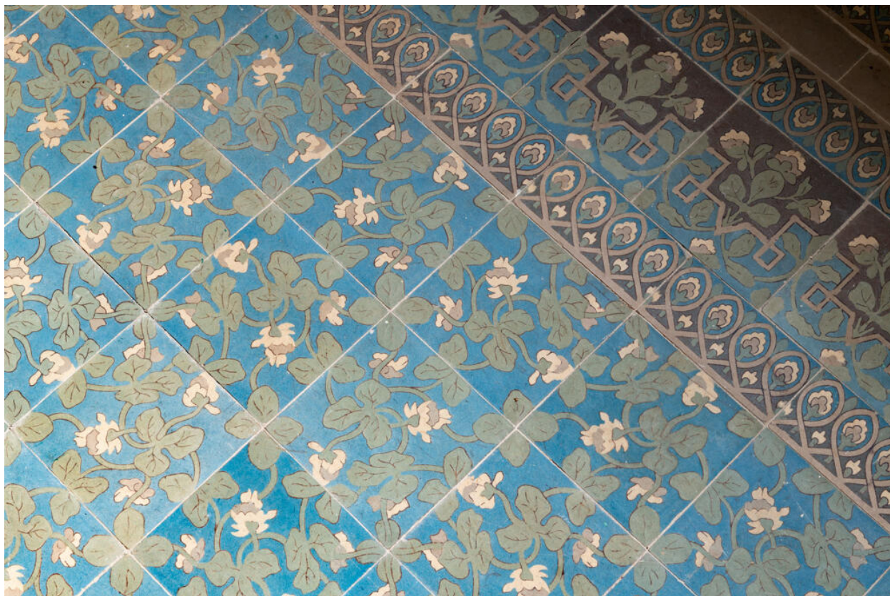
Sol en carreaux de ciment de la chambre sud-est au premier étage.
