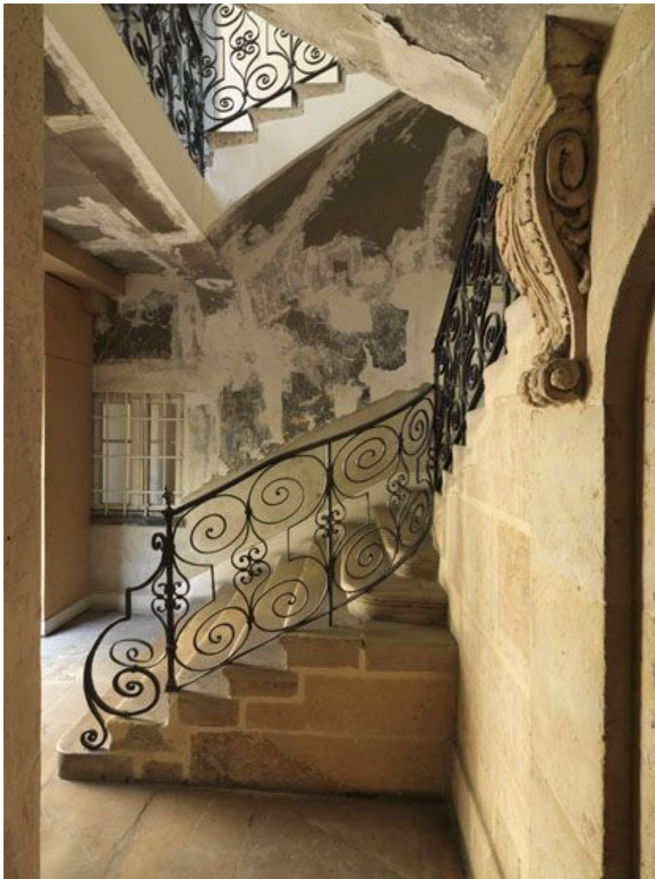
Détail du départ de rampe.
